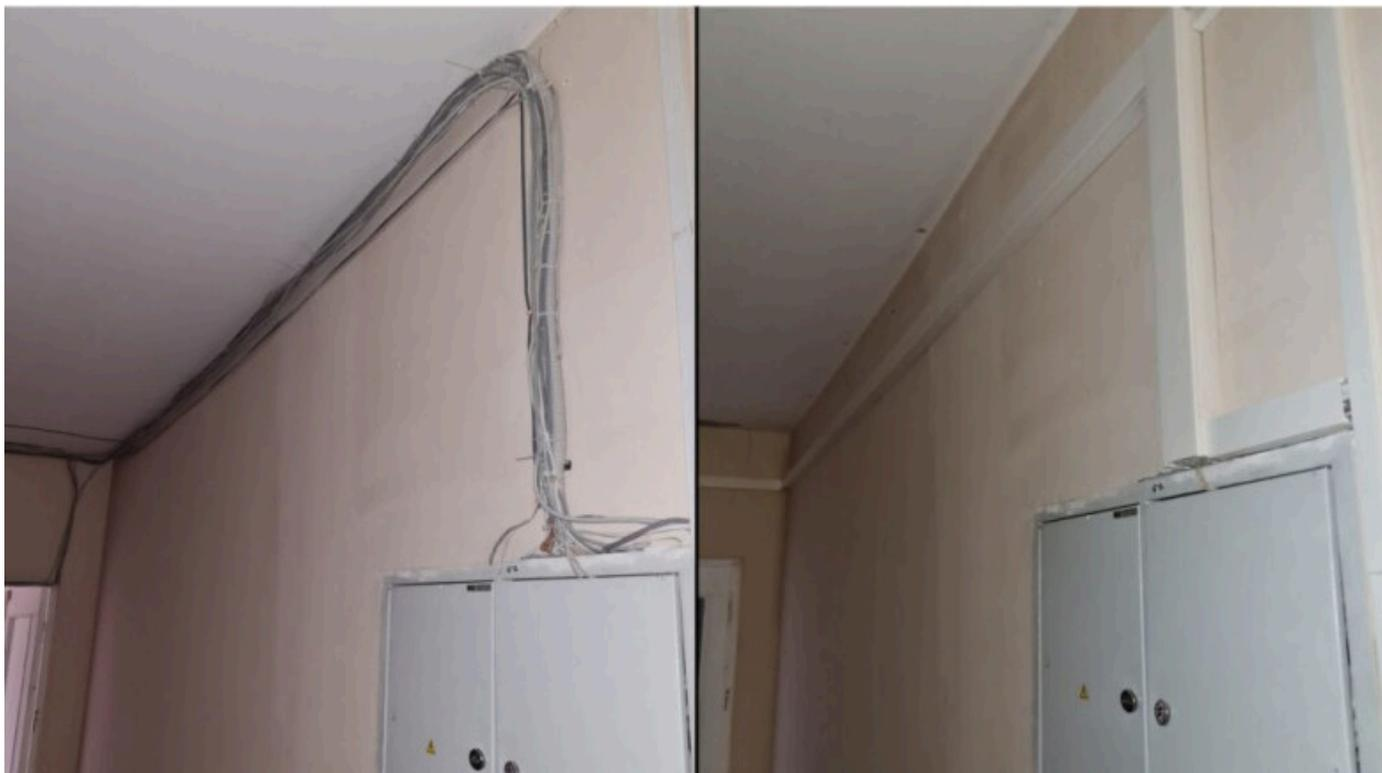
Фото из интернета до и после монтажа кабельного канала
