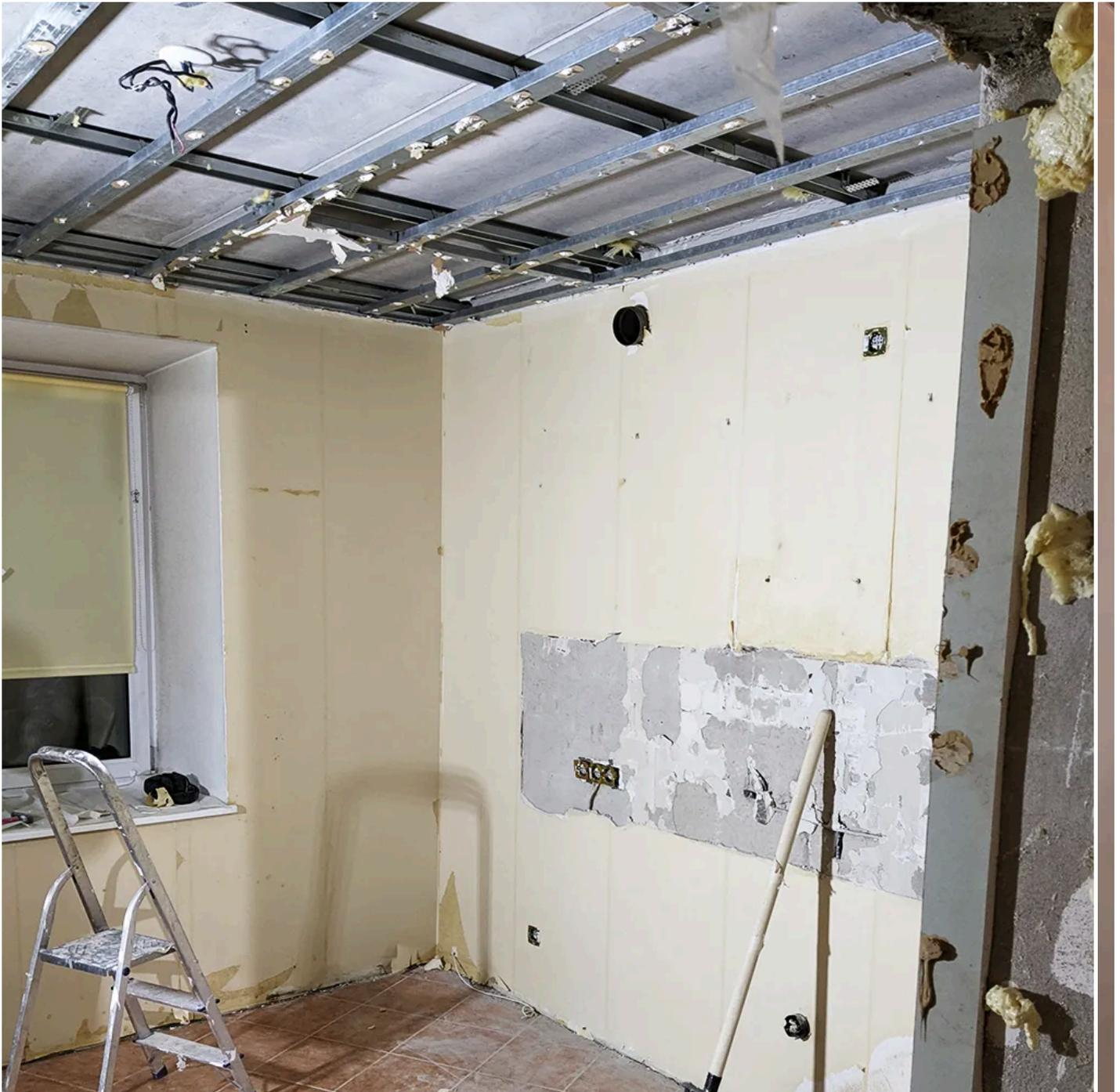
1/3 Здесь видна конструкция потолка после того, как рабочие сняли гипсокартон. Думаю, такой потолок съедает не меньше 10 см пространства
