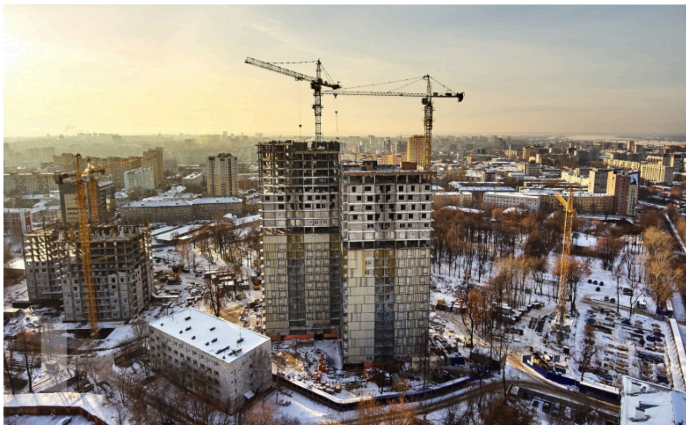
Строительство нашего дома в процессе — ноябрь 2016 года
