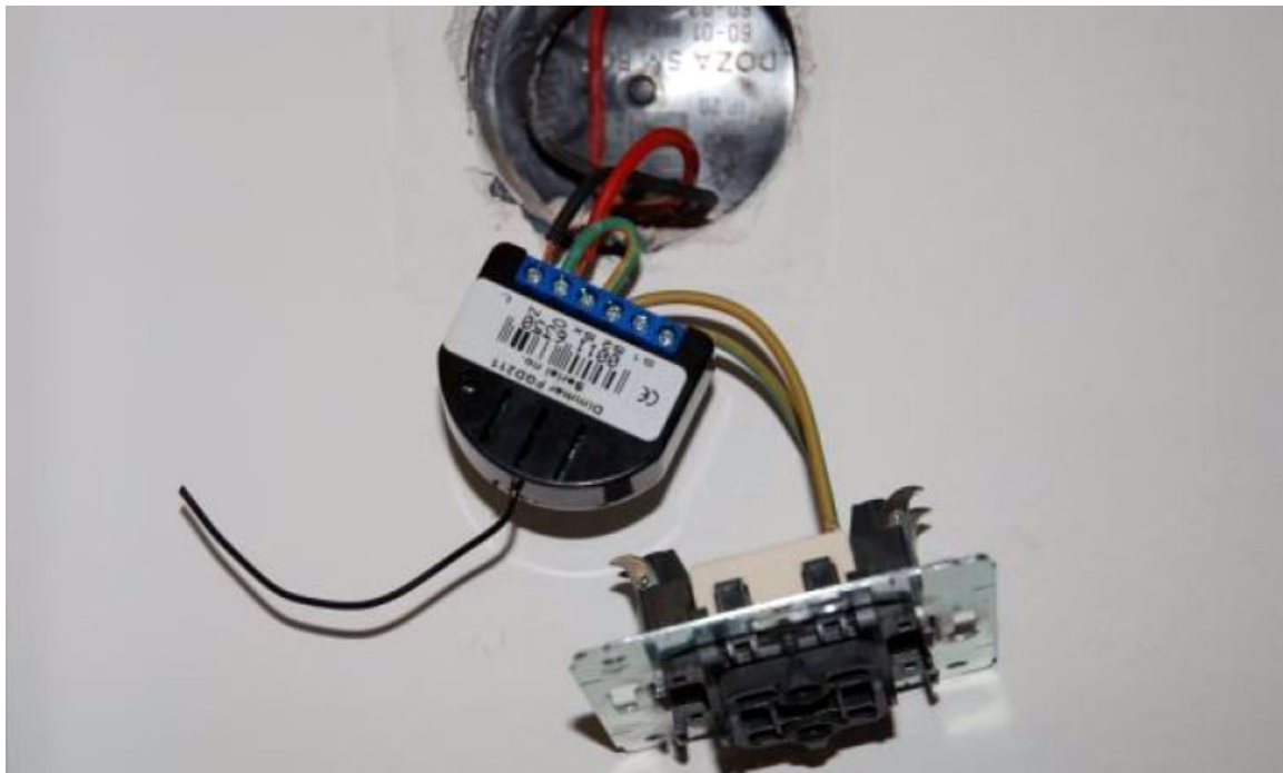
Рис. 7. Подключенный универсальный диммер компании Fibaro
